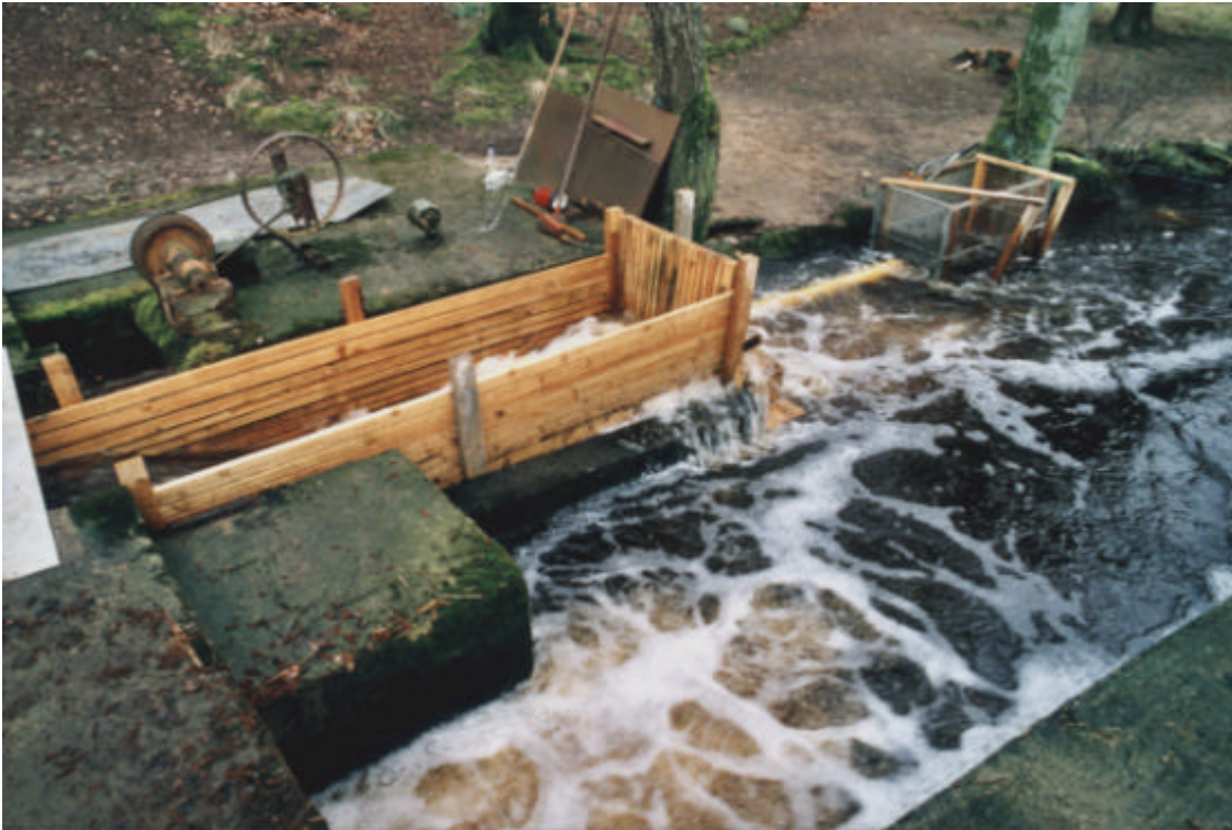
Figur 23. Den nyanlagda fasta smoltfällan vid Lunnagård, Norrån (foto Hans Schibli).
